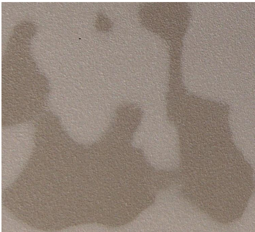
Kulörskiftning efter regn på fasad som lagats partiellt.
