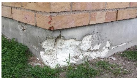
Bild 1 a, b, c. Skador på sockelelement.
