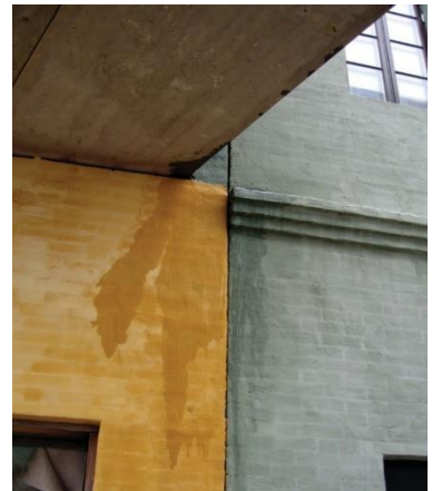
Vattenrinning från balkong på fasad.
