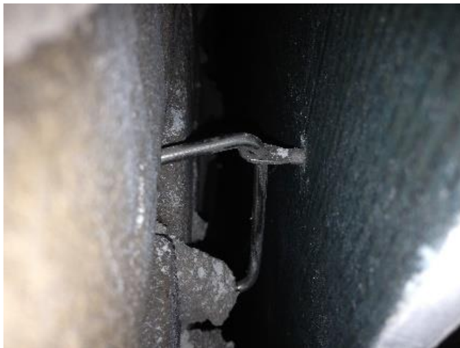
Bild 2. Felaktig montering av ledad kramla. Bygeln bör inte vara placerad så att den låses i ett hörnläge.
