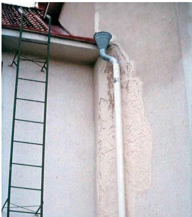
Frostskada orsakad av täppt stuprör.
