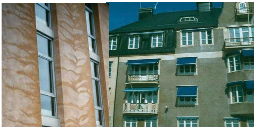
Två exempel på fasader med mer eller mindre flammighet.
