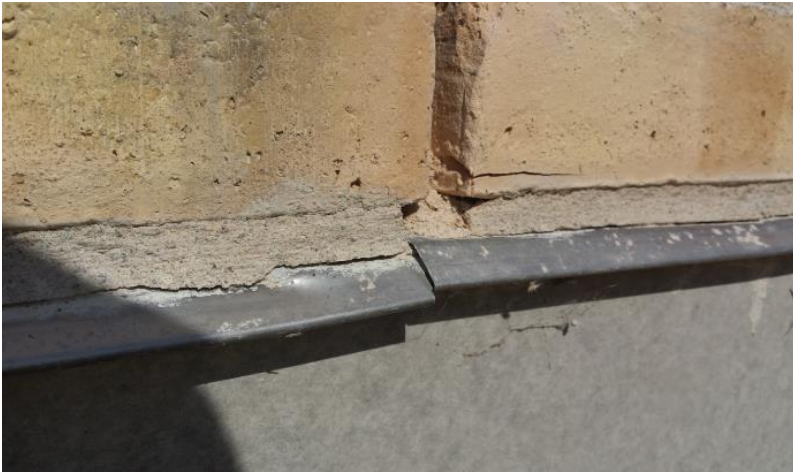
Bild 1. Upplag av ½-stens tegelmur på felaktigt monterad underlagsplåt.
