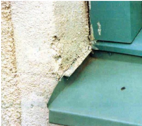
Dålig anslutning av puts mot fönsterbleck och karm.
