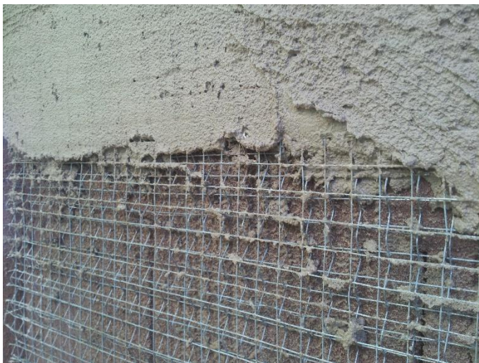
Rätt placering av nätarmering i utstockningsputs.
