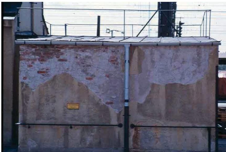
Kraftiga frostsador på puts där hängränna tidigare har saknats.
