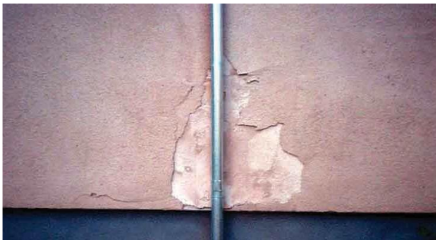
Läckande stuprör kan medföra omfattande frostsador.
