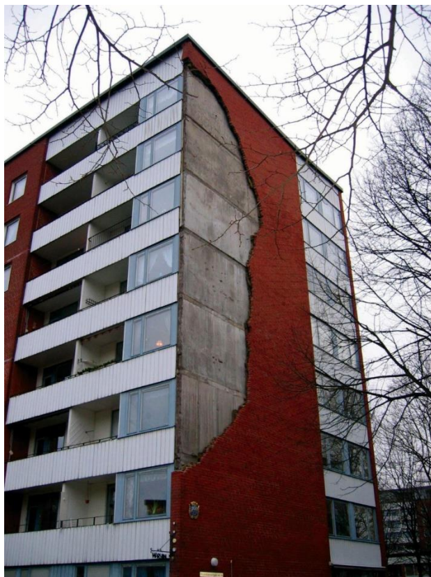
Fasadras efter stormen Gudrun i januari 2005.
