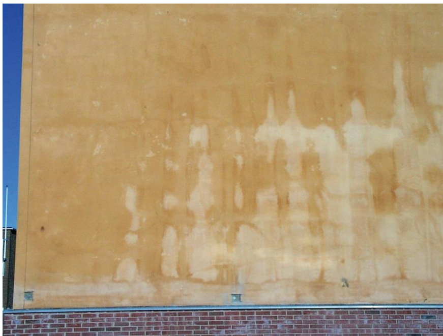
Vid målning med KC-färg på en KC-putsad fasad uppstod störande kulörskiftningar.
