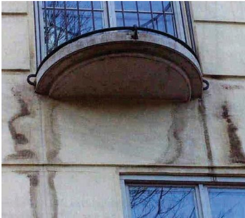
Dålig vattenavledning vid balkong.
