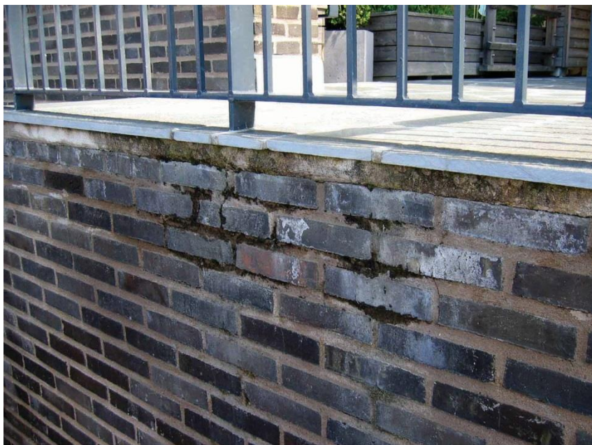
Vattenläckage och algpåväxt på stödmur.
