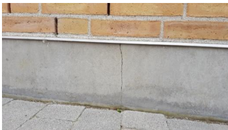
Bild 2. Sprickbildning på sockelelement.
