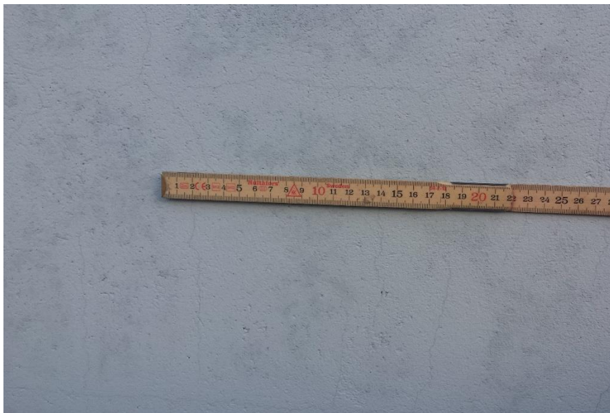
Sprickor i armerad puts på lättklinkerblock.
