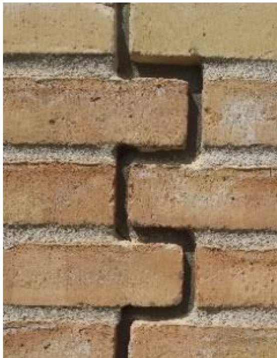
Bild 3. Dilatationsfog, som följer fogen. I detta fall är ett expanderande fogband monterat men fogning återstår.
