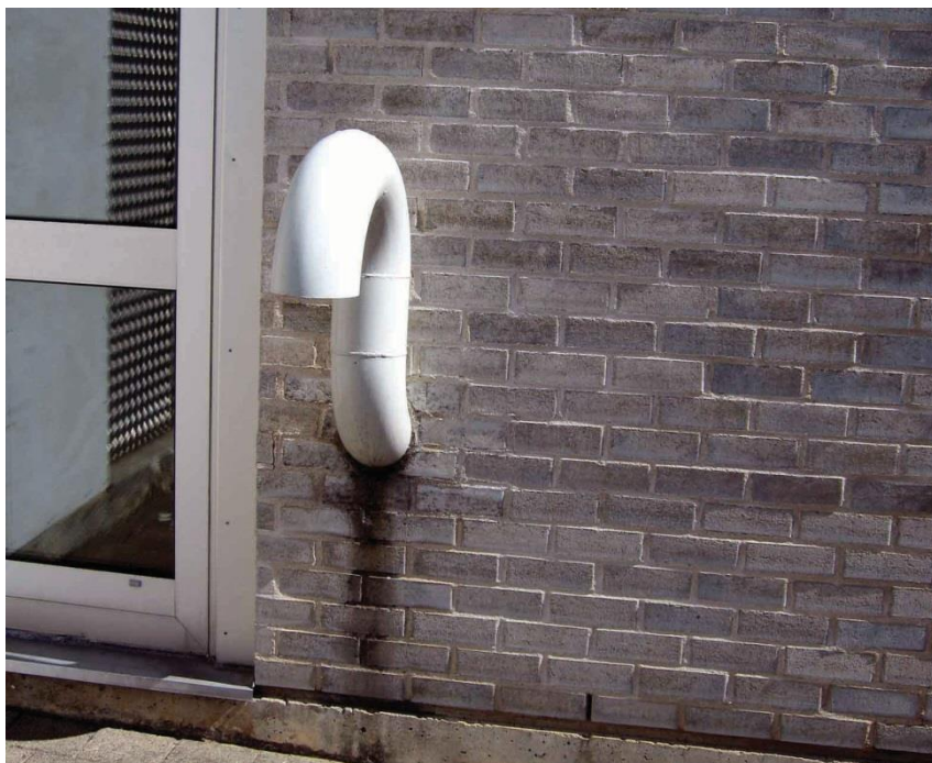
Regn- och kondensvatten från ventilationsrör leds in mot fasaden.
